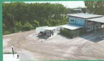
ฉีดพรมน้ำตามแนวถนนในพื้นที่เหมืองเพื่อลดฝุ่นบริเวณโรงโม่
