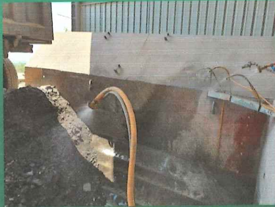
ระบบสเปรย์น้ำ เพื่อลดฝุ่น
