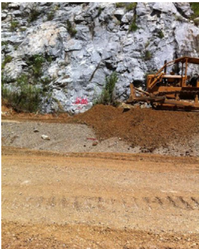
รูปที่ ๒-๑๑ การปรับสภาพพื้นที่โดยเครื่องจักรกลหนัก
