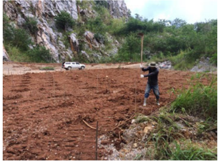
รูปที่ ๒-๑๔ การวางแนว ปักหมุดและขุดหลุม
