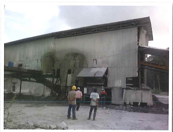
การตรวจวัดปริมาณฝุ่นละอองโดยวัดค่าความทึบแสง ที่จุดกำเนิดฝุ่นของโรงโม่หิน
