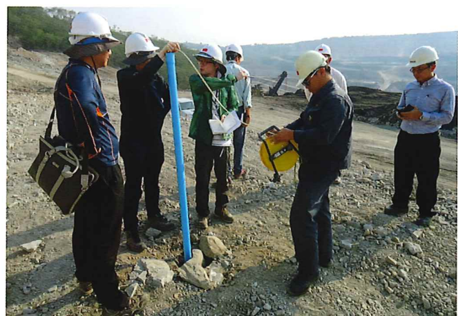
การติดตั้งอุปกรณ์ Thermal Line Sensor
