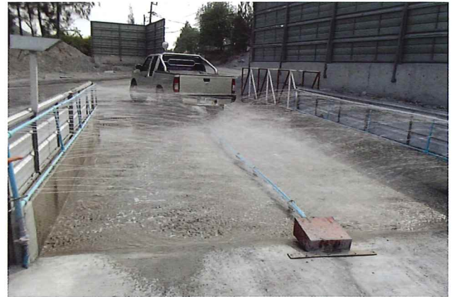
การปรับปรุงลานล้างล้อรถก่อนออกพื้นที่โรงโม่
