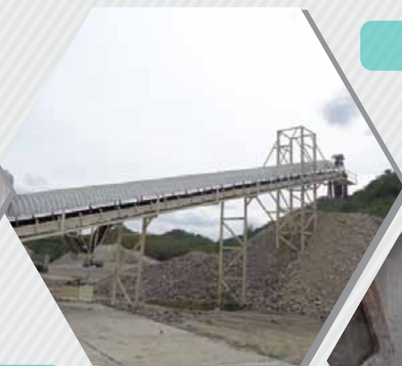
ระบบปิดคลุมสายพาน
