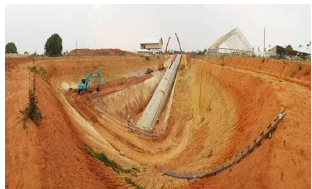
อุโมงค์เอียงเข้าสู่ชั้นแร่โพแทชที่อำเภอด่านขุนทด จังหวัดนครราชสีมา
